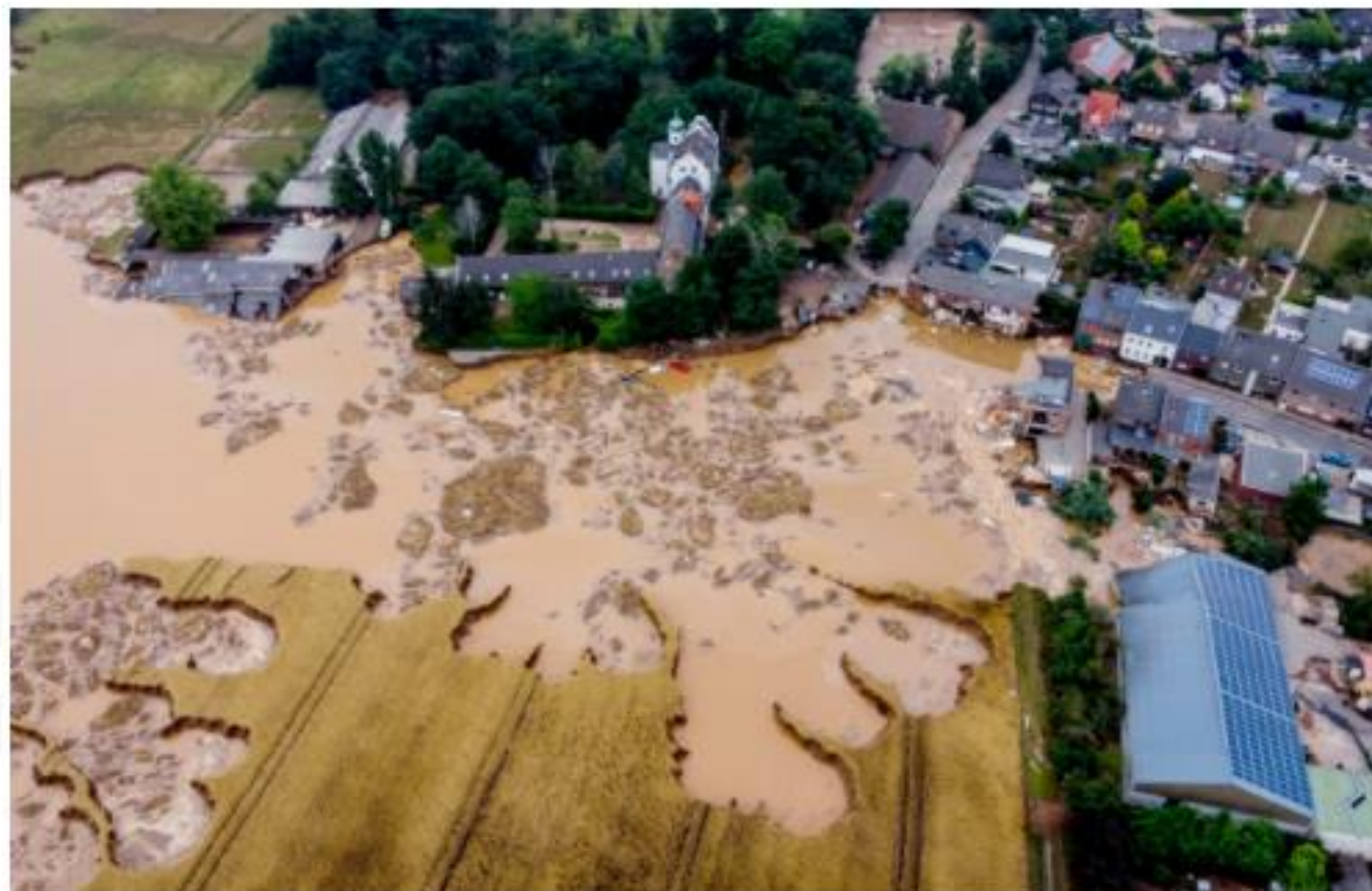
Aufgrund starker Regenfälle ist der kleine Fluss Erft in Ertstadt-Blessem über die Ufer getreten und hat massive Schäden verursacht. (© picture alliance / ASSOCIATED PRESS | Michael Probst)
